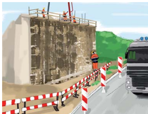
Rys. 5 Zabezpieczenie prac na wysokości balustradą ochronną
