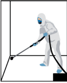
Rys. 1 Odzież ochronna i środki ochrony indywidualnej przy pracach impregacyjnych i odgrzybieniowych
