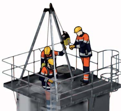
Rys. 2 Zastosowanie trójnogu ewakuacyjnego przy robotach w studzienkach kanalizacyjnych
