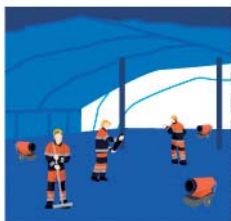
Rys. 2 Wykonywanie prac pod cieplakiem
