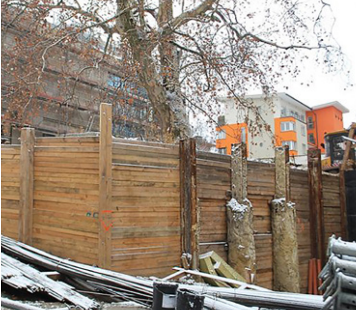
Fot. 6. Grudzień 2012 / styczeń 2013 – głębokie wykopu poza zakresem rzutu korony przy użyciu technologii zabezpieczenia wykopu ścianką szczelną (fot. Dominika Krop-Andrzejczuk)
