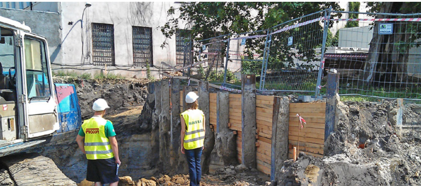
Fot. 5. 2012 – rozpoczęcie wykopów poza zakresem rzutu korony przy użyciu technologii zabezpieczenia wykopu ścianką szczelną; nie dopuszczono do wykonania kondygnacji podziemnych metodą wykopów otwartych (fot. Dominika Krop-Andrzejczuk)
