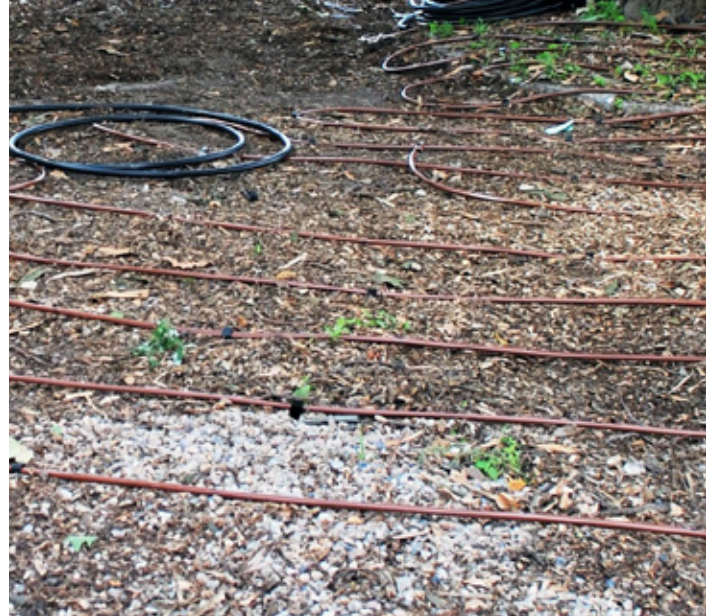
Fot. 7. 2012 – instalacja systemu nawadniania powierzchni strefy korzeniowej, funkcjonującego przez cały czas trwania budowy, z przerwami na sezon zimowy (fot. Dominika Krop-Andrzejczuk)
