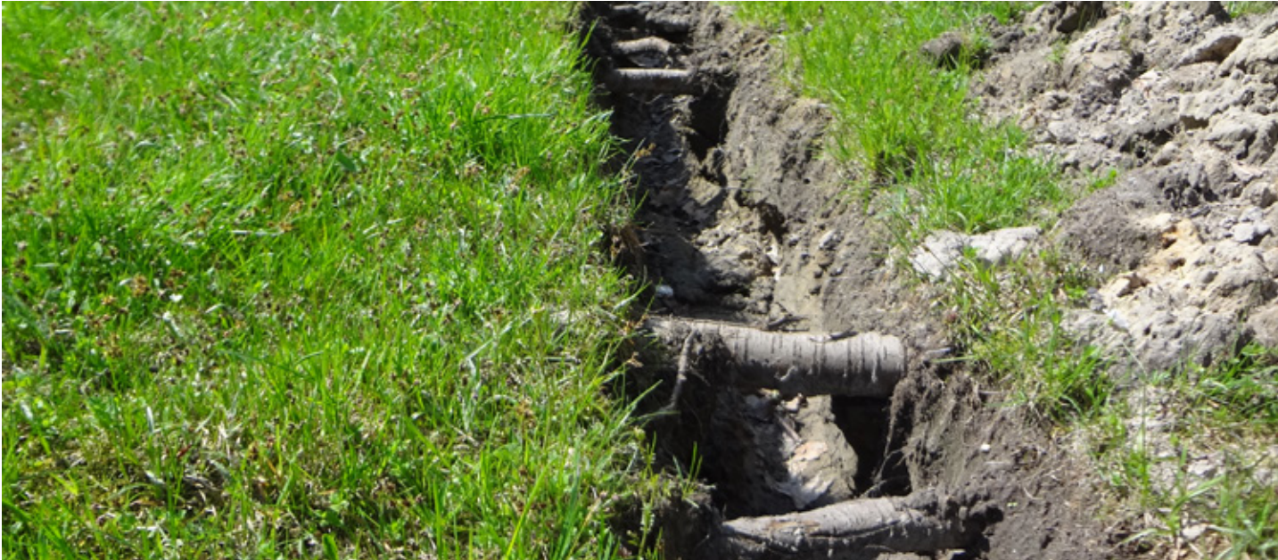
Fot. 21. Otwarty wykop z pozostawieniem korzeni drzewa bez ich przecinania
